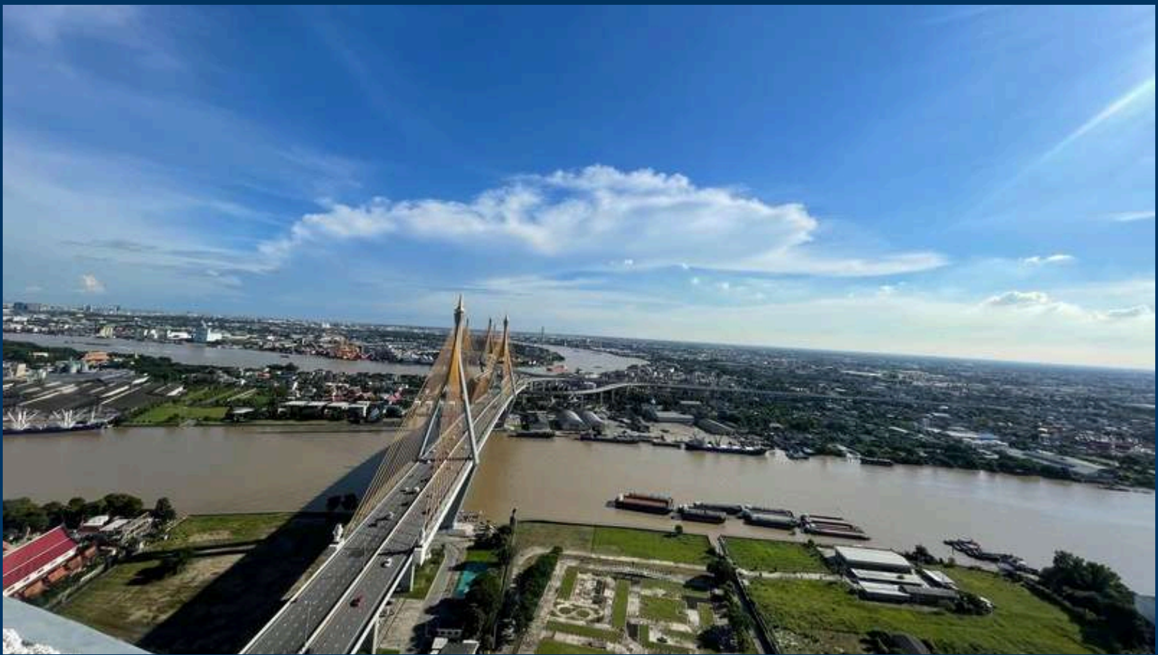
View ชั้น 41 facility
